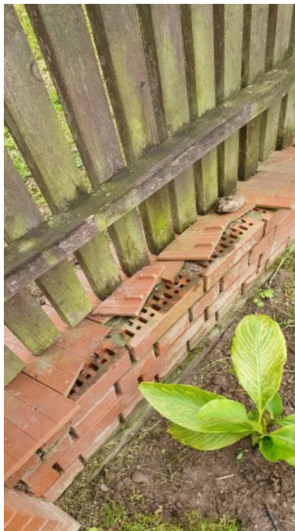
Uszkodzone dachówki ceramiczne na cokole
